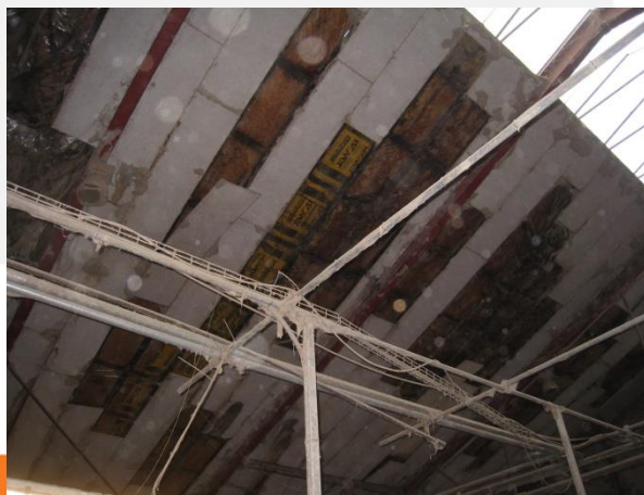
Foderlade – utæt tag, gulvet skruk efter rotter
